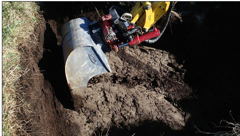
Kaivaminen on edistynyt pohjasaveen (kerrostunut jääkauden aikana, Baltian jääjärveen).
